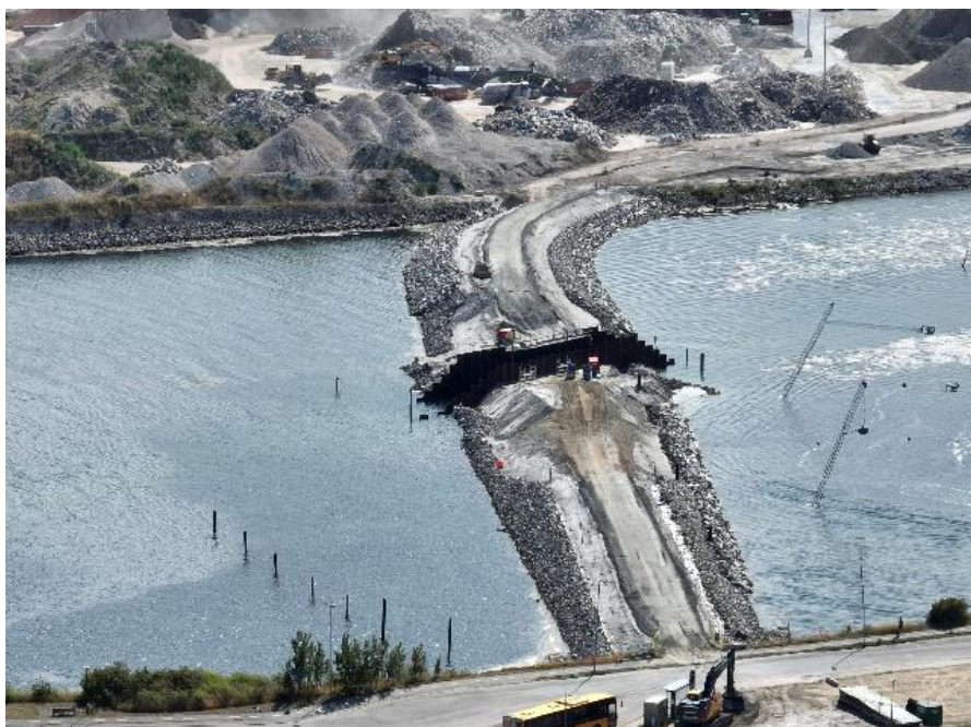
Fig. 3 Vejdæmning over Prøvestenskanalen
