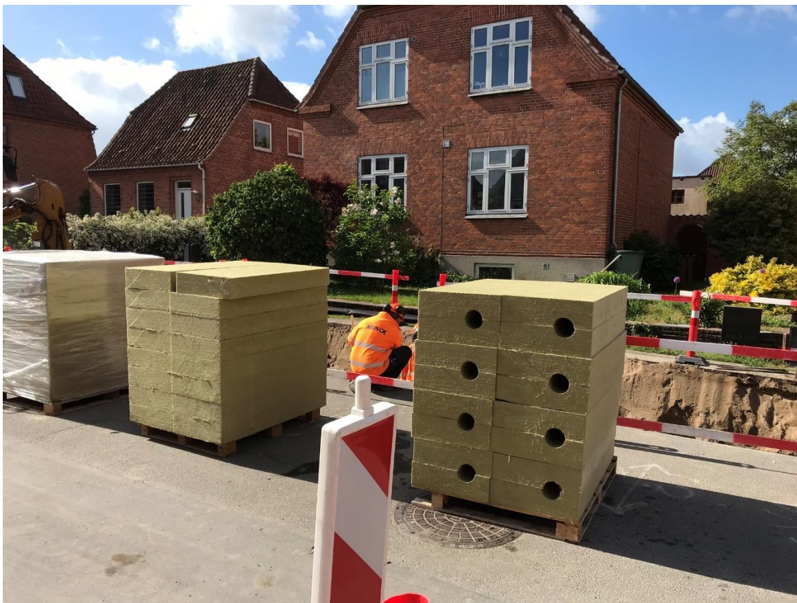
Figur 2: Rockflow fås med dimensioner på 120x100x15 eller 120x50x15 som vist på billedet. Fordelingskanalen er udskåret, så den ligger i samlingen mellem to bats. Til brug for filtre skal der være en fordelingskanal i toppen af anlægget og en tilsvarende fordelingskanal i bunden til at tømme anlægget.
