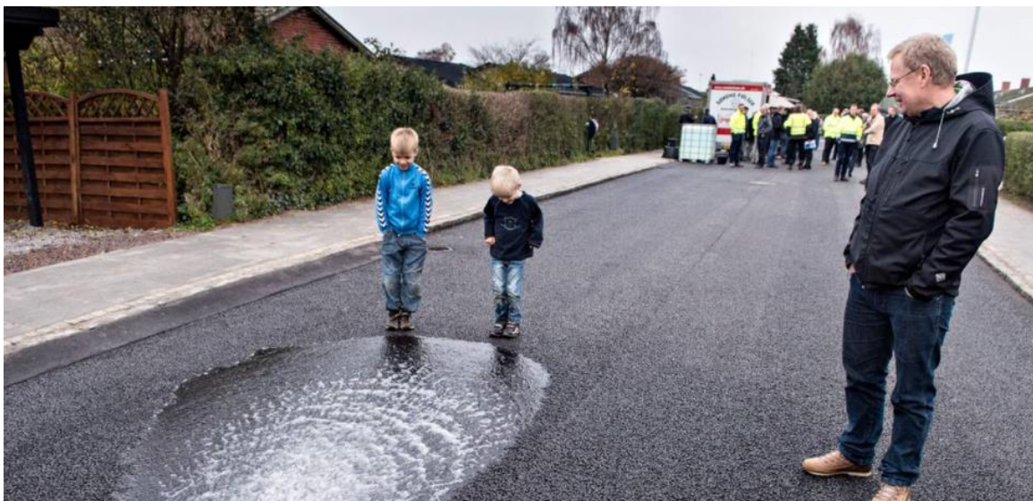
Figur 8: Ved afledning gennem en permeabel belægning vil vandet blive filtreret før det når det underliggende magasin samtidig med, at magasinet kan etableres med en stor overflade og derved med en stor hydraulisk kapacitet og et stort magasin volumen
