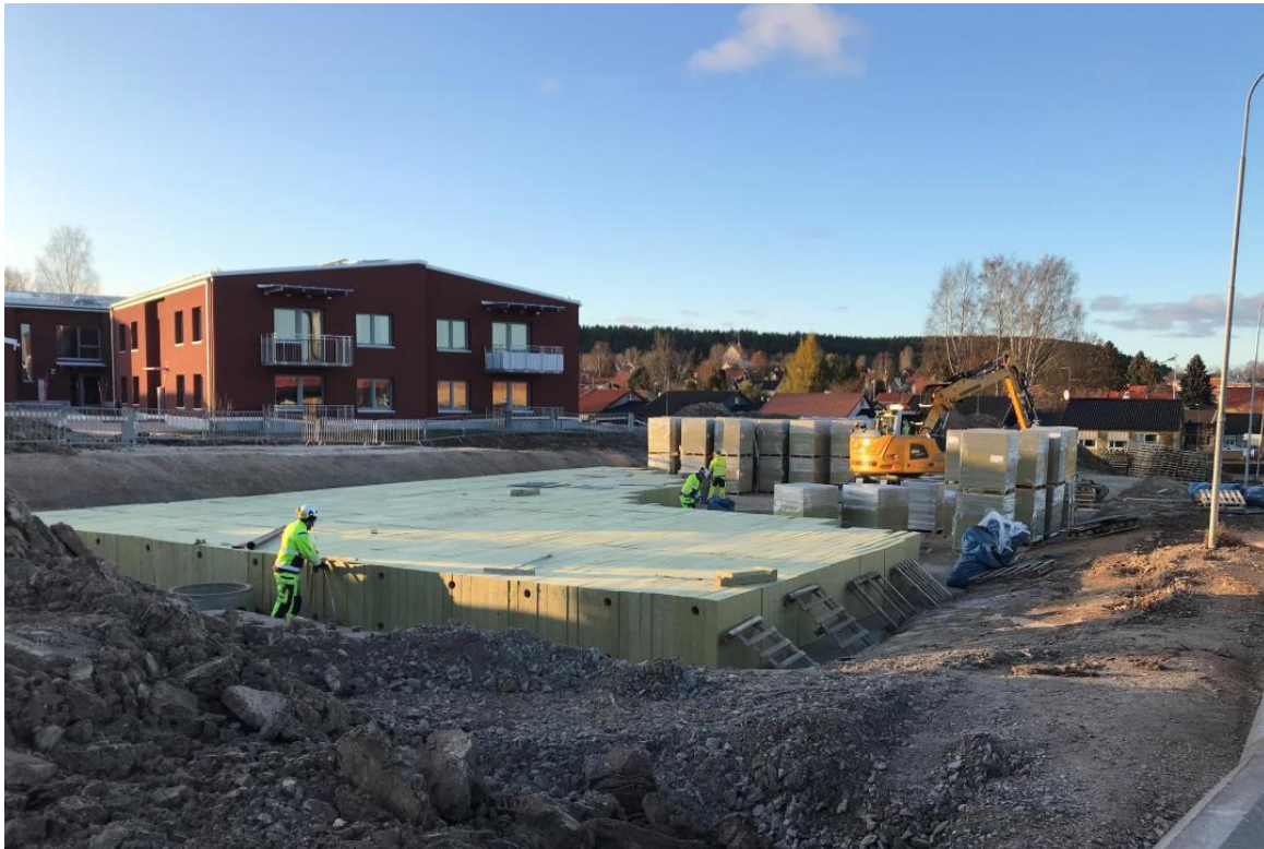
Figur 13. Det 600 Rockflow bassin blev anlagt på 20 arbejdstimer. Efter elementerne var sat, kunne der bygges jord ind omkring bassinet og anlægges parkeringsplads. Bemærk, der ikke skal bruges geotekstil.
