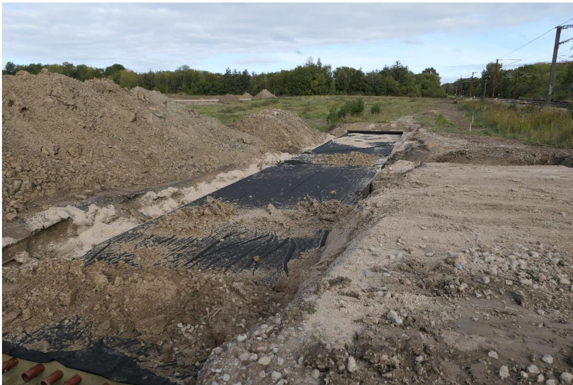
Figur 15. Rockflow filter anlagt under byggemodningsindledning og klar til at få udlagt jord og etableret vej- og p-plads.
