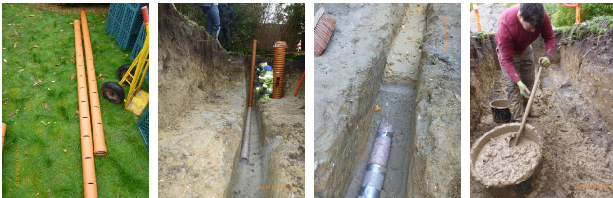
Foto: Nedlægning af opsamlingsrør til prøvetagning.
