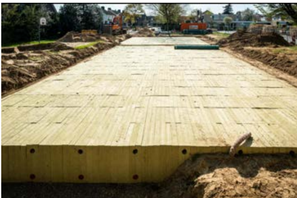
Figur 1: Rockflow fås som elementer, der kan bygges sammen til et magasin. Elementerne fås både med og uden udfræsning af fordelingskanal
