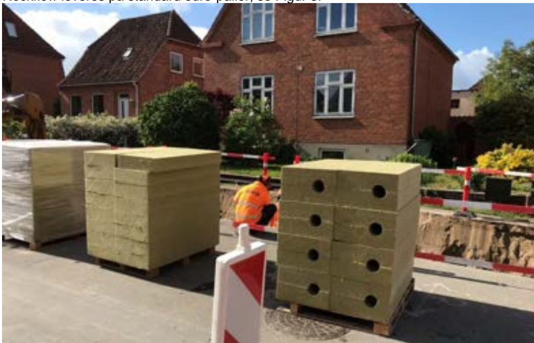
Figur 3: Rockflow fås med dimensioner på 120 \times 100 \times 15 eller 120 \times 50 \times 15 som vist på billedet. Fordelingskanalen er udskåret, så den ligger i samlingen mellem to bats. Til brug for filtre skal der være en fordelingskanal i toppen af anlægget og en tilsvarende fordelingskanal i bunden til at tømme anlægget.
