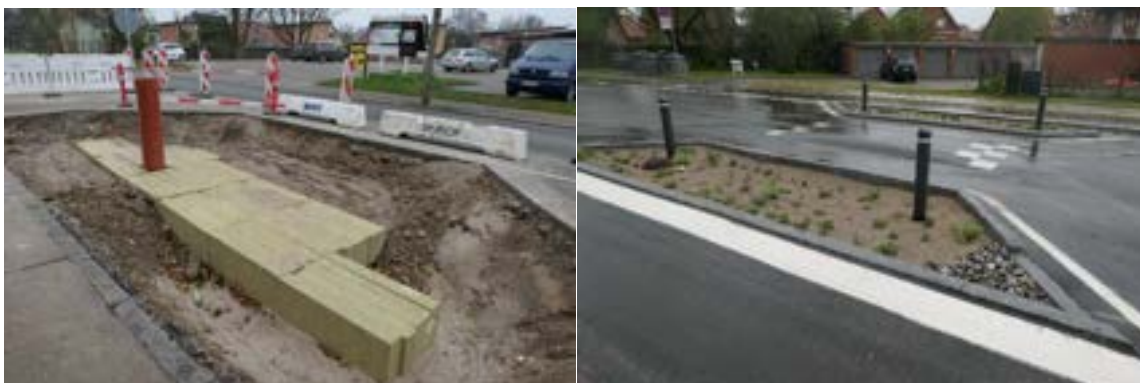
Figur 20: Eksempel på vejbed, hvor regnen siver ned gennem filtermulden til en underliggende faskine eller et magasin, som kan etableres i Rockwool. I områder med leret og derfor dårlige nedsivningsforhold vil en faskine, der kan rumme en 10-årshændelse, af hensyn til de lange efterårsregn være så stor, at den også kan rumme en væsentlig del af et skybrud. Anlægget kan på den måde både nedsive hverdagsregn og bidrage til skybrudshåndtering.
