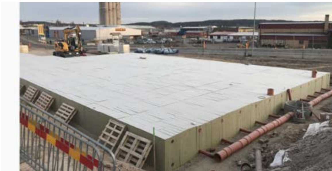
Figur 18: Rockflowmagasin anlagt som forsinkelse før afledning til kloak. Hedemora, Sverige. I det viste tilfælde er der anvendt en afstand mellem indløbskanalerne på 1,2 m, og tilløb sker modsat anvisningens anbefaling i bunden af anlægget.
