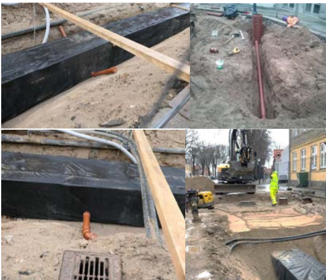
Figur 10: Øverst tv. To tværstillede Rockflow batts med en kanal i bunden og/eller top gør det muligt at koble vejbrønde til anlægget. Øverst th. Rørføring monteres i kanalen på de to tværstillede Rockflow batts og forbindes med vejbrønd eller tagedløb. Midt Tv. Rørføring fra bassin (pakket ind i membran. Midt Th. Rendestensbrønd med sandfang med rørføring til bassin. Nederst TV. Tilslutning mellem rendestensbrønd og Rockflow bassin. Nederst TH. Vejbrønd og rensebrønd til magasin indpakket i membran, tildækket med grus.
