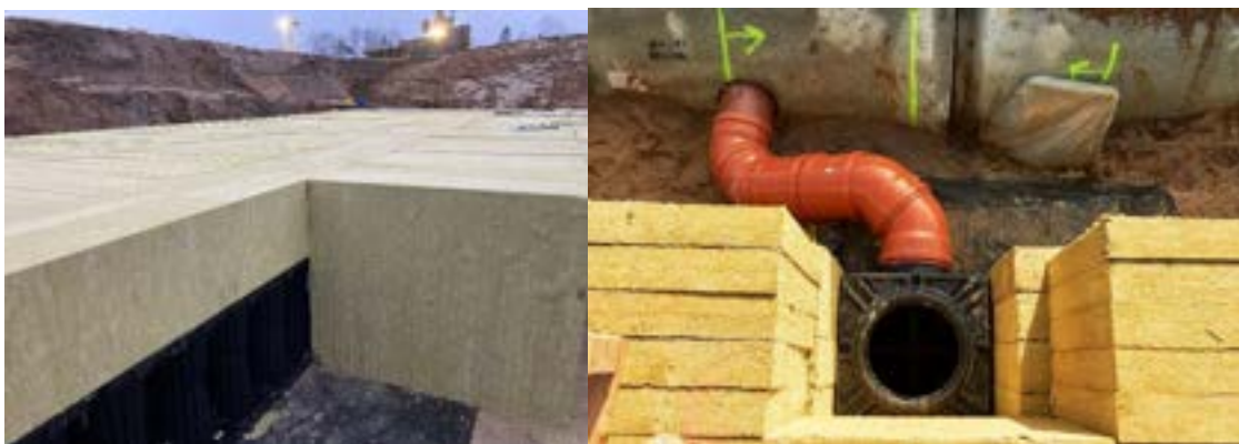
Figur 14: Vandet kan også fordeles i anlægget ved at lægge en plastfaskine (sort) mellem sektioner med Rockflow-bats. Den sorte tilløbsbrønd(th) fungerer som sandfangsbrønd og giver mulighed for at spule plastfaskinen.
