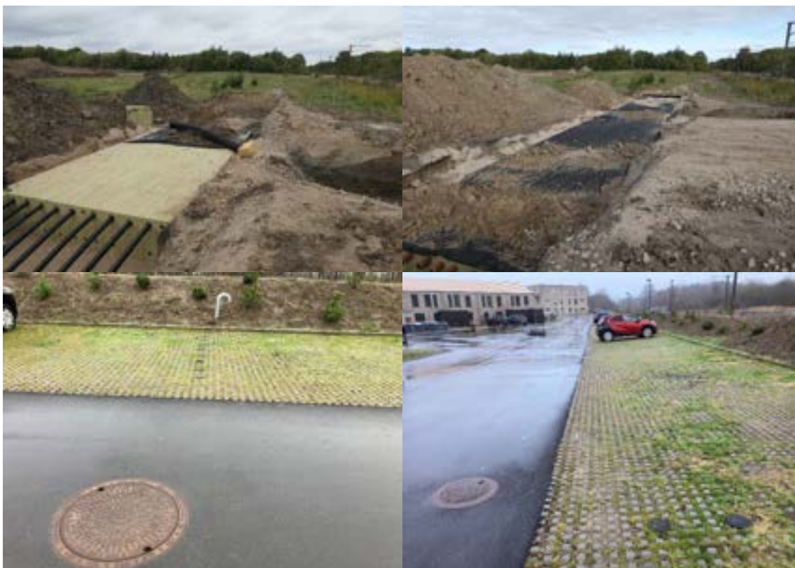
Figur 30: Øverst tv og th. Rockflow filter anlagt under byggemodningsindledning og klar til at få udlagt jord og etableret vej- og p-plads. Nederst. Systemet i drift. TV. Den ene af to indløbsbrønde. Herefter dæksler til inspektion og rensning af indløbskanaler og svanehals til udluftning. Th. dæksel til indløbsbrønd og tre inspektions- og rensedgange i p-areal.
