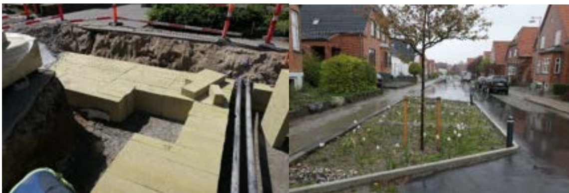
Figur 27. TV: Under anlægsarbejdet blev fjernvarmerør tilpasset ved at udskære traceer i Rockflow elementerne. Et Plantehul er sat tv. før fjernvarmeledningerne. TH: Det færdige og beplantede vejbed, hvor træet står i det viste plantehul.
