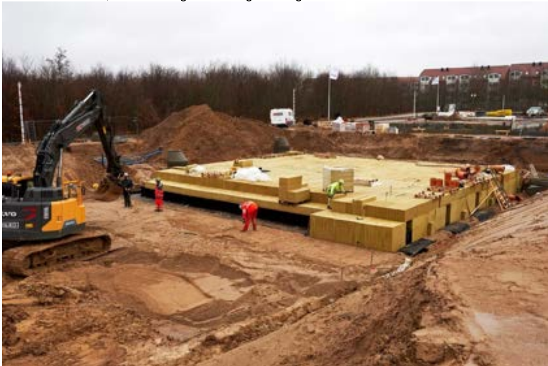
Figur 26: Etablering af forsinkelse og rensebassin Januar 2022. Indløb via til rækker af plastkassetter, med inspektions- og renseadgang.
