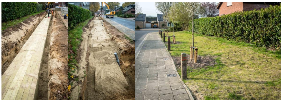
Figur 12. TV: Rockflow elementerne blev anlagt som et aflangt bassin, da det passede med området. Bassinet afvander ved nedsivning. MIDT: Efter elementerne er sat, tilføres fyldmaterialer rundt om og over anlægget. TH: Afslutningsvis blev der sået græs og sat træer.
