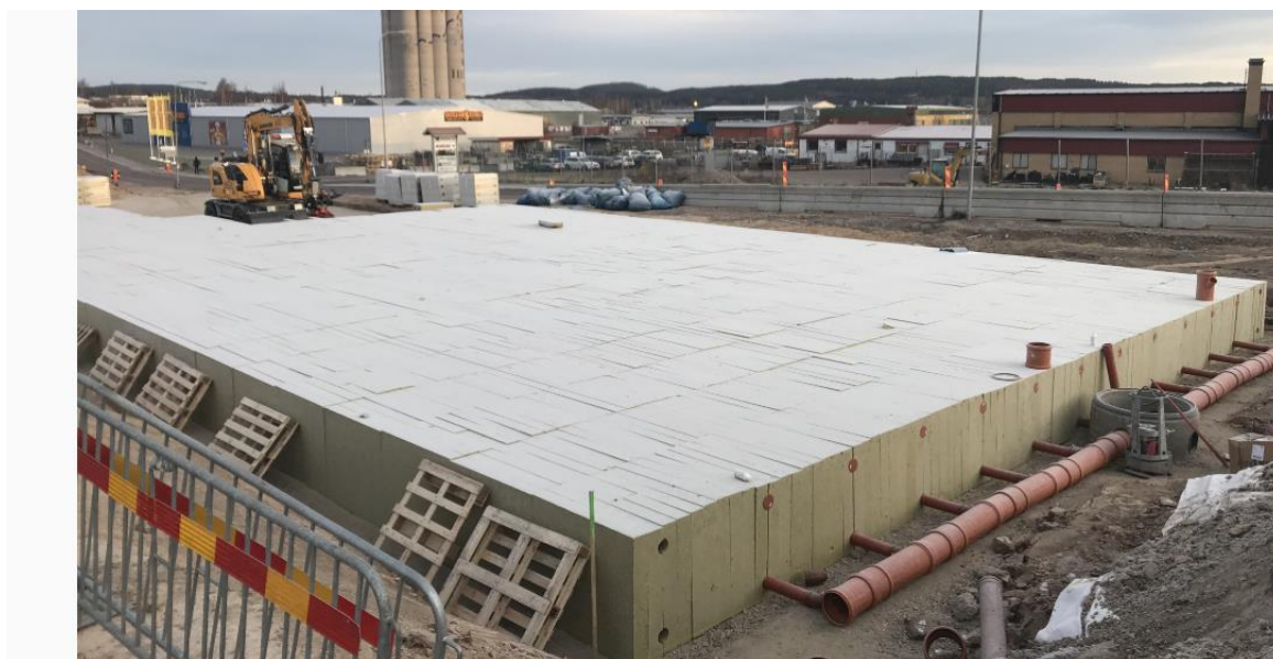
Figur 6: Figur: Rockflowmagasin anlagt som forsinkelse før afledning til kloak. Hedemora, Sverige.
