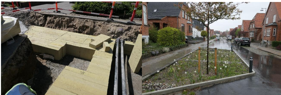
Figur 14. TV: Under anlægsarbejdet blev fjernvarmerør tilpasset ved at udskære traceer i Rockflow elementerne. Et Plante hul er sat tv. for fjernvarmeledningerne. TH: Det færdige og beplantede vejbed, hvor træet står i det viste plante hul (billede tv).
