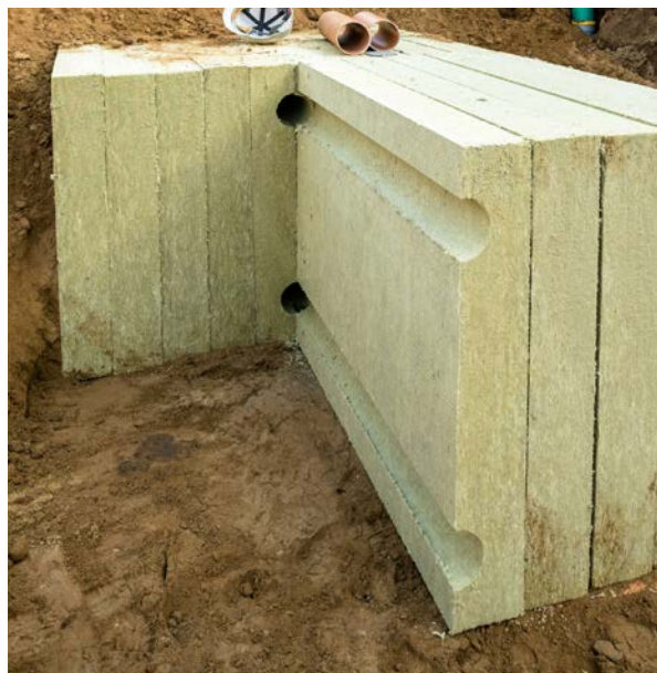
Regnvandssystem med Rockflow.
