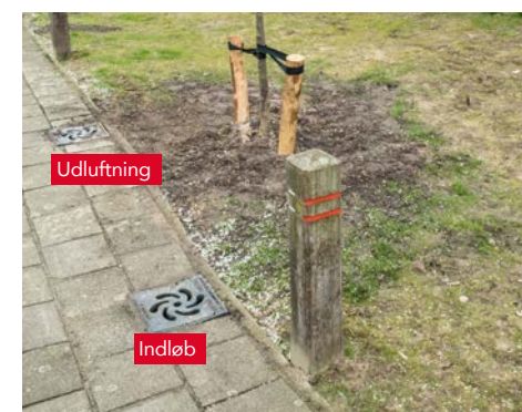
Udluftning sker via den øverste udskårne kanal og kan føres via en vejbrønd eller en separat rist eller svanehal.
