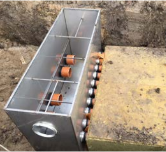
Filteret kan dimensioneres til det ønskede indløbsflow, forsinkelse og levetid.
