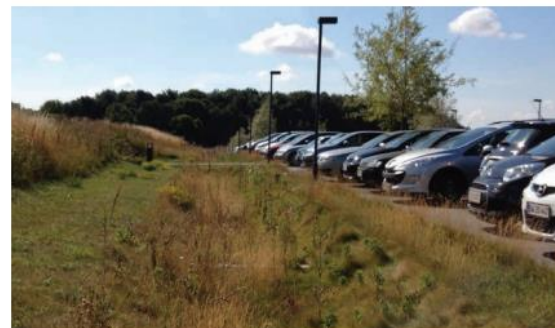
Nedsivningsanlæg ved parkeringsplads. Det regnvand, der nedsives, skal være så rent, at grundvandsforekomsten fortsat kan opfylde sit miljømål. Risiko for grundvandsforurening beror på regnvandets faktiske eller forventede forureningsgrad og grundvandforekomstens sårbarhed.
