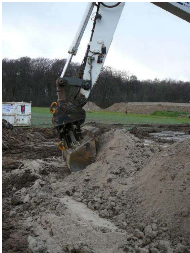
Figur 9. Muld og sand blandes til filterjord på lokaliteten.
