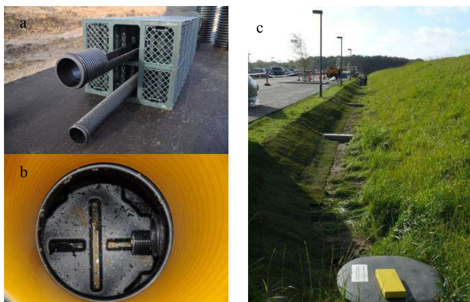
Figur 5. a: Plastkassette med nedre drænrør samt gennemskåret drænrør til opsamling af gennemdrypsvand under filterjorden. Begge rør er forbundet med prøvetagningsbrønden. b: kig ned i brønden hvor begge drænrør er synlige. c: Vestlig grøft mod syd. Prøvetagningsbrønd nederst i billedet.
