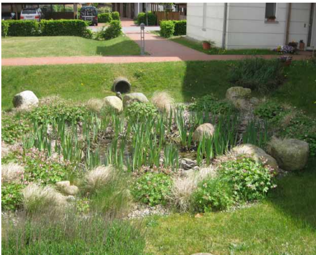
Regnbed integreret i forhaven. Rækkehusbebyggelse i Flensborg. Foto: Orbicon.
