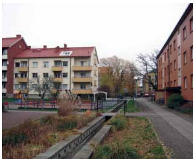
Regnvandskanaler tilpasset eksisterende boligområde, Augustenborg, Malmø. Foto: Rosalina W. Torgard, SCA
