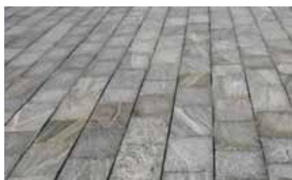
Granit med brede fuger, Ørestad Foto: København kommune
