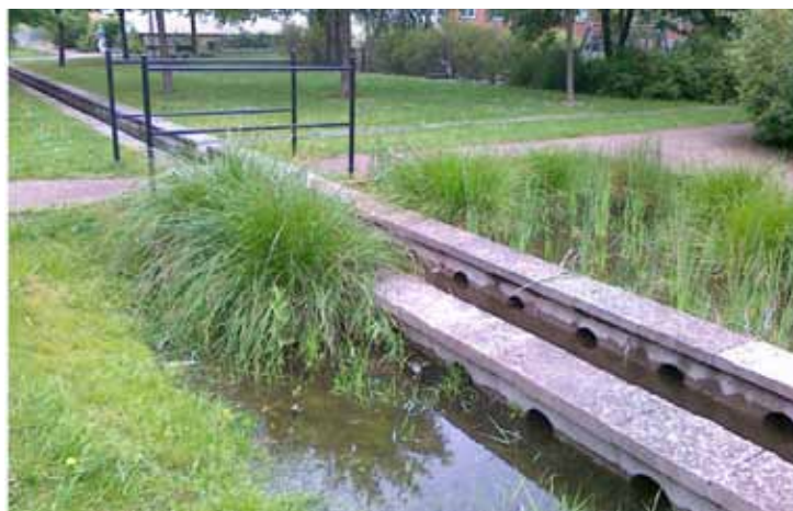
Fyldt infiltrationsgrøft, Augustenborg, Malmö - Foto: Orbicon
