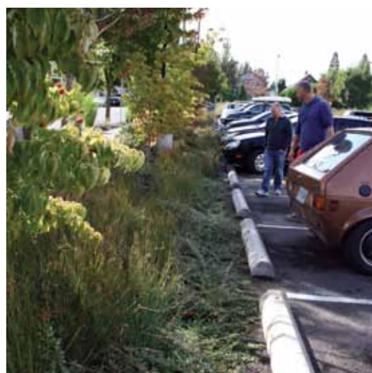
Afvandning af parkeringsplads, Portland Foto: Orbicon
