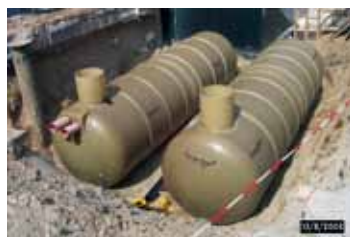
Nedgravet regnvandstank Foto: Nyrup Plast opsamling
