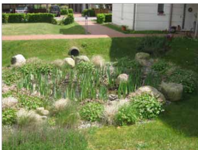
Regnbed anlagt i forhave ved rækkehusbebyggelse i Flensborg Foto: Orbicon
