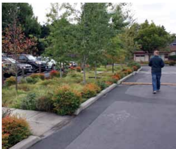
Regnbed ved parkeringsplads, Mt. Tabor School, Portland. Foto: Orbicon
