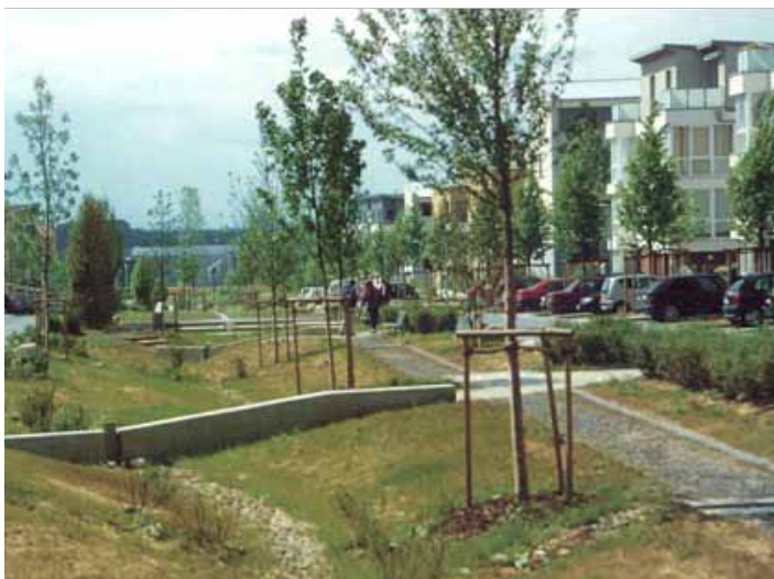
Grøn kile til kombineret nedsivning og bortledning af regnvand, Kronsberg, Hannover. Foto: H. Dreiseitl
