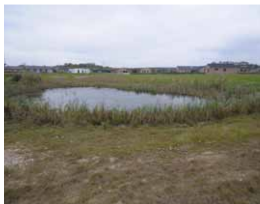
Traditionelt regnvandsbassin for separat regnvand.
