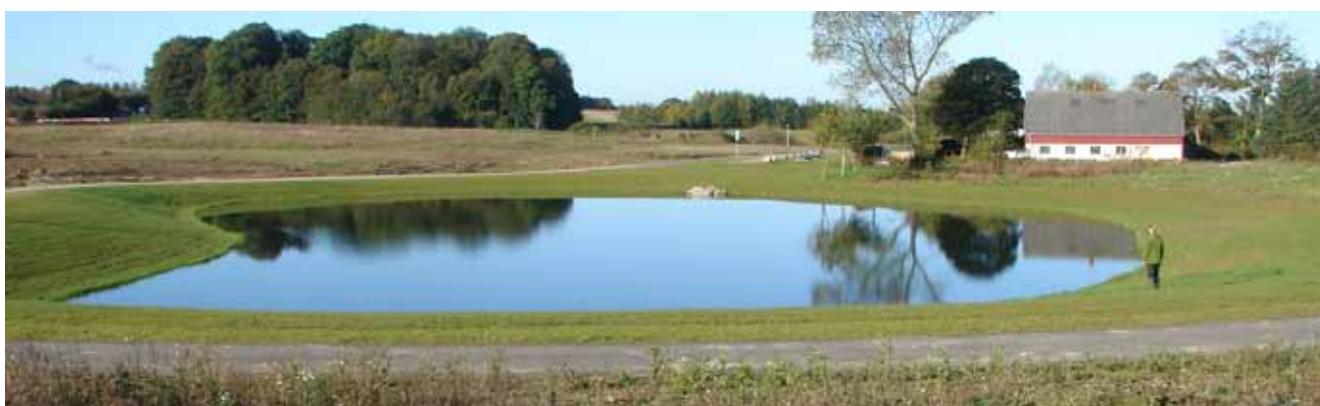
Traditionelt regnvandsbasin til forsinkelse og rensning af separat regnvand, Kolt, Aarhus Kommune. Foto: Kaj Vestergaard.
