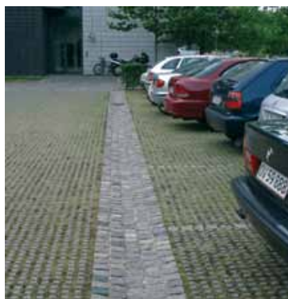
Permeabel belægning Foto: Jane Schul
